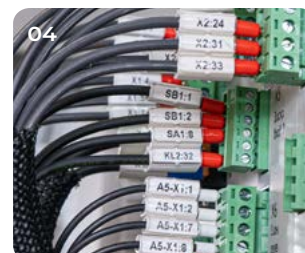
04 Отделите и установите держатель на проводник
